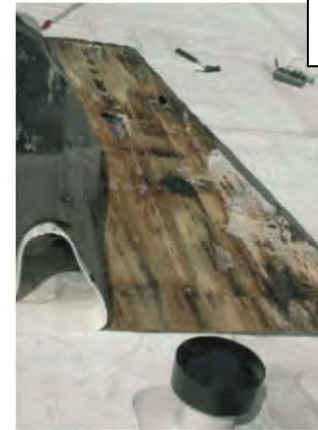
Figura 2.41 - Carie bruna all'interno di una stratigrafia sopra tavolato esterno (Fonte: Rolfsmeier et al. 2017)
