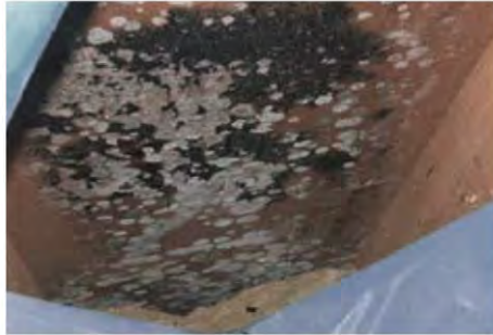
Figura 2.40 - Carie bruna all'interno di una stratigrafia sotto tavolato esterno (Fonte: Krus, Sedlbauer 2002)
